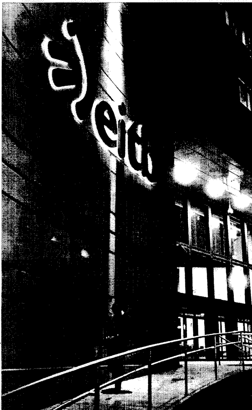
Fachada principal de la sede central de la radio televisión pública vasca en Bilbao. / MATA
